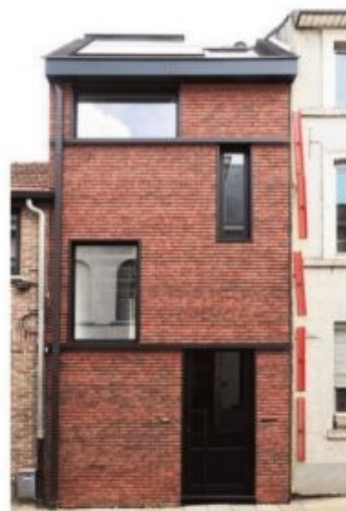
De smalle starterswoning biedt ondanks een breedte van drie meter toch veel ruimte en licht.
